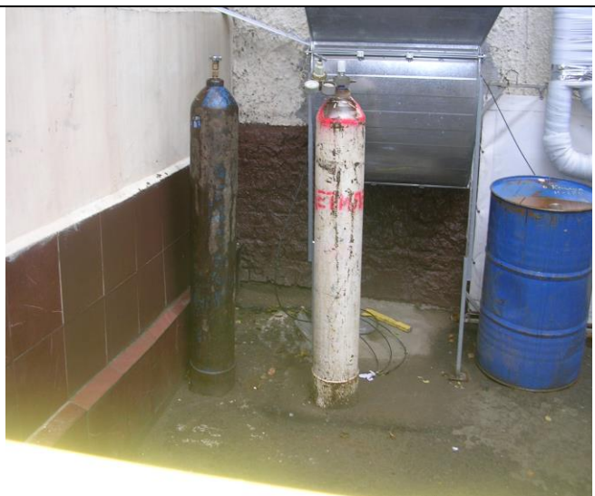
Кислородный и ацетиленовые баллоны хранятся с нарушением Правил устройства и безопасной эксплуатации сосудов, работающих под давлением.
